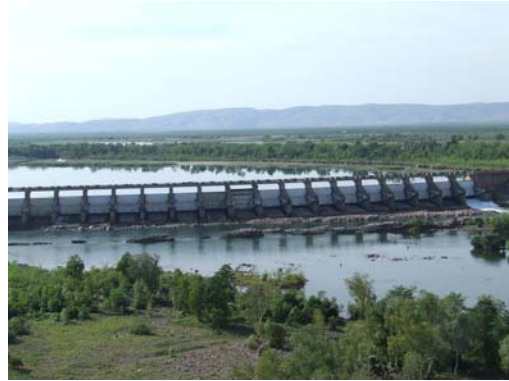
Kununurra Diversion Dam
